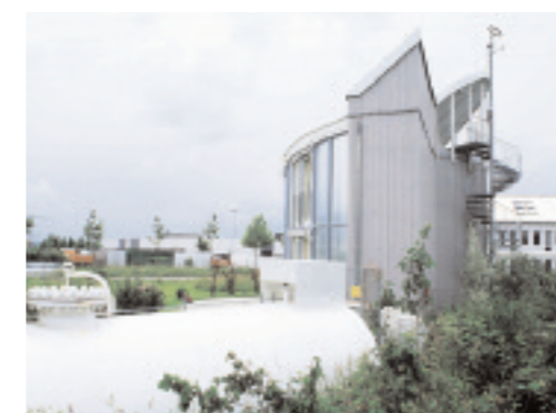
Serbatoio per idrogeno di una casa completamente alimentata dall'energia solare. L'idrogeno generato per elettrolisi viene usato per cucinare e per alimentare fuel-cell che forniscono elettricità nei periodi di bassa insolazione.
