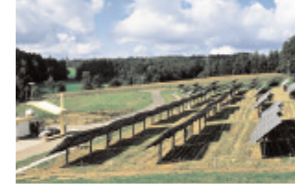
Stazione di rifornimento di idrogeno, per auto. L'idrogeno viene estratto dall'acqua grazie alla corrente elettrica fornita dalle batterie solari fotovoltaiche (a destra).
