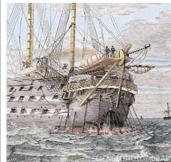
La nave Agamemnone mentre posa il primo cavo telegrafico transoceanico. Il primo sfortunato tentativo fu condotto nel 1857. Il successo fu conseguito il 5 Agosto del 1858. Il cavo era rivestito di guttaperca e pesava 625 kg/km. Oggi le telefonate transoceaniche sono possibili da ogni luogo grazie ai telefoni satellitari.
