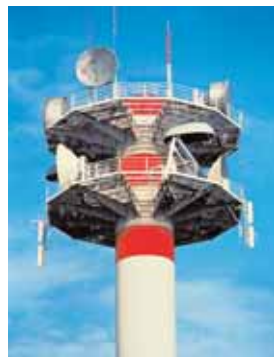
Una stazione ripetitrice a microonde. Torri come questa sono usate per ricevere e ritrasmettere telefonate e dati. Le antenne paraboliche emettono il segnale verso altre torri simili, fra le quali non devono essere presenti ostacoli.
