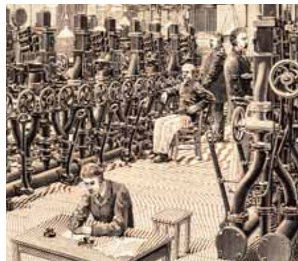
Illustrazione storica del sistema di posta pneumatica di Parigi, nel XIX secolo. I gruppi di tubi che si vedono a sinistra e a destra nel disegno sono terminali di ricezione e di invio delle capsule contenenti i messaggi. Le capsule viaggiavano lungo i tubi grazie alle differenze di pressione generate con grandi compressori ed era possibile raggiungere velocità fino a 40 km/h. La rete della posta pneumatica nel 1884 si estendeva a tutta la città. Il sistema fu chiuso solo nel 1984.
