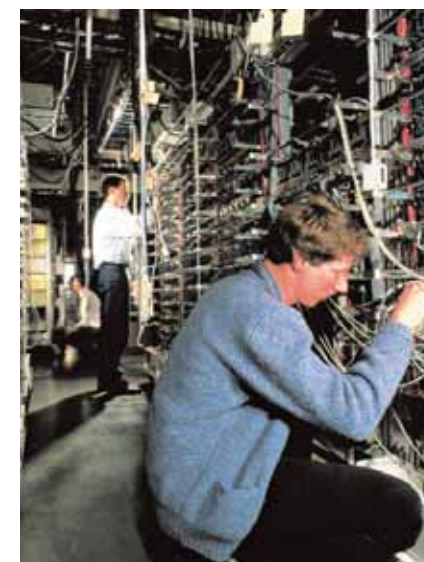
Tecnici al lavoro su una centrale telefonica di scambio. Stanno effettuando un test sui circuiti di commutazione. L'indirizzamento di ogni telefonata verso l'apparecchio ricevente avviene automaticamente, sia per le telefonate nazionali che internazionali, grazie all'interpretazione del numero richiesto secondo un codice prestabilito.
